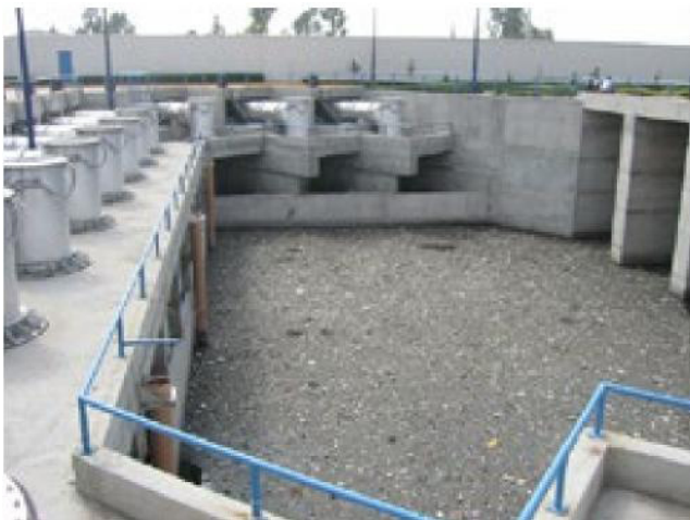
Voorbeeld van een typisch afvalwaterstation met propellerpompen.
