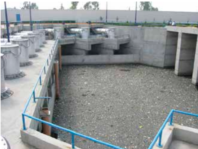
Afbeelding 1: Een pompput voor vuil water bedekt met drijvend afval.
