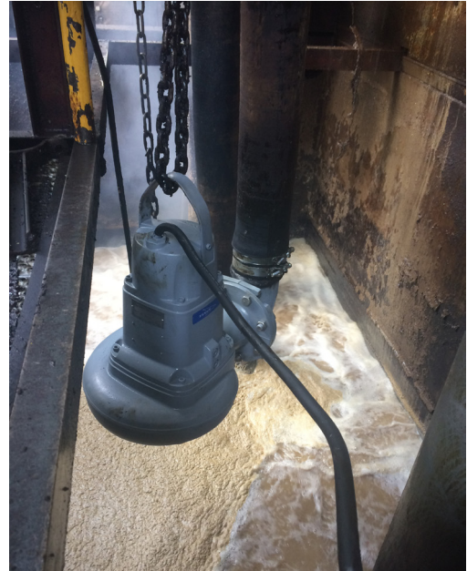
De Flygt Concertor wordt in de ontvangstput geplaatst bij de isolatiemateriaalproducent.
