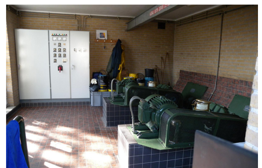
De buiten- en binnenkant van het betreffende vijzelgemaal in Oosterhout
