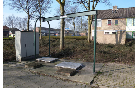
De oude situatie, naast het vijzelgemaal
