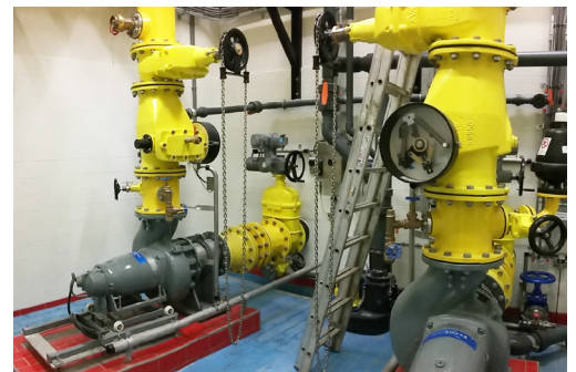
De Z-stand met Flygt NZ 3153 pompen in de Pelgrimstraat, Rotterdam.
