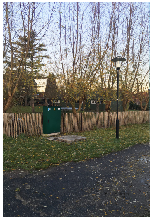
Een aangepaste schakelkast bij een gemaal in Sluis, voor het optimaliseren van het afvalwatertransport.
